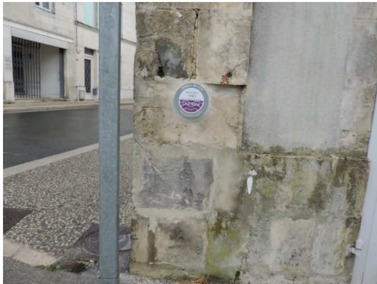
Repère installé sur le musée archéologique de Saintes
