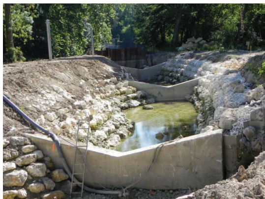
Passé à poissons de Jarnac en chantier
