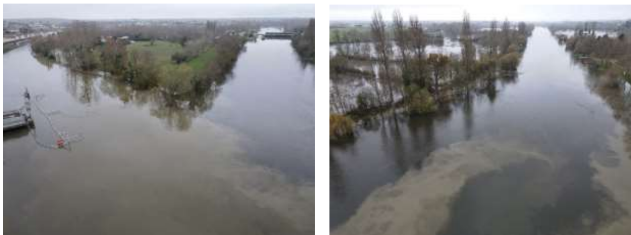
Figure 43 : Clapet totalement submergé et vannes ouvertes le 23 novembre 2023 à 15h49, photo Eauceá. Le panache de turbidité illustre la complexité de l'analyse du mélange des eaux issus des deux bras.
