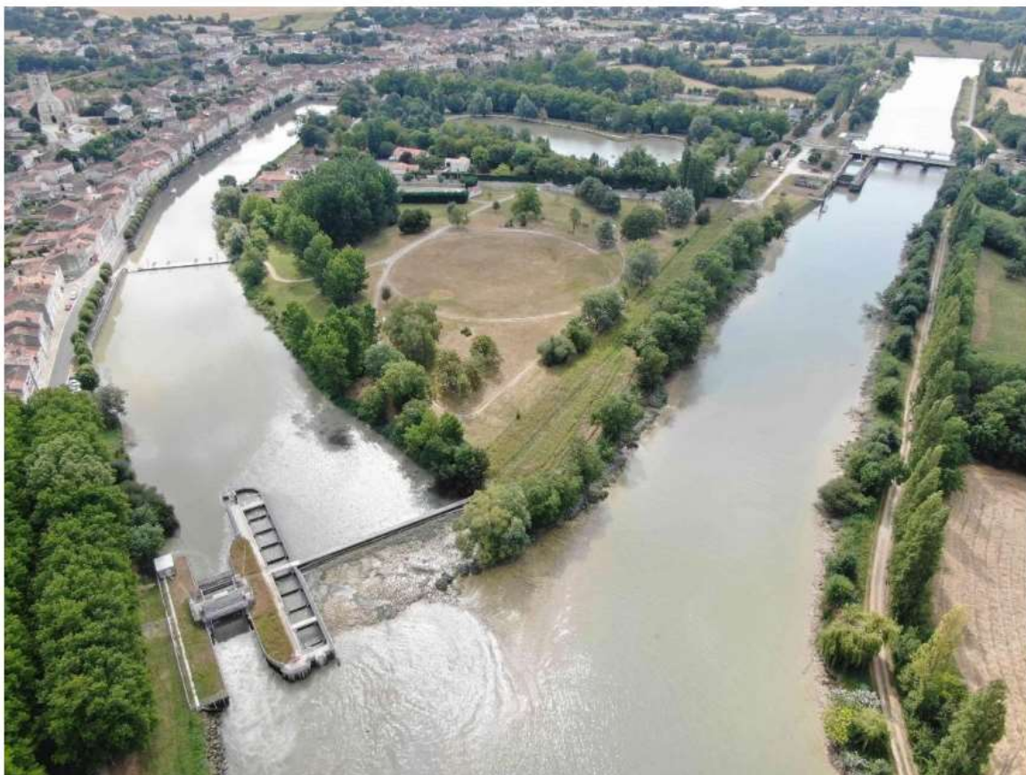
Figure 37 : Vue aérienne des ouvrages hydrauliques de Saint-Savinien (Damien Filloux, MIGADO) (SZCZEPANIAK et al. 2022)
