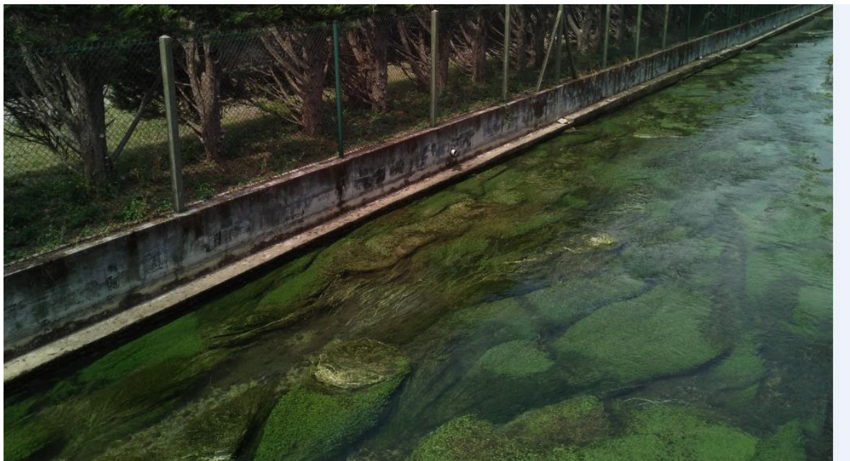
Figure 11 : Photographie illustrant l'impact des herbiers aquatiques de la Maillerie sur les écoulements. Toute la section est encombrée (source Eaucea).
