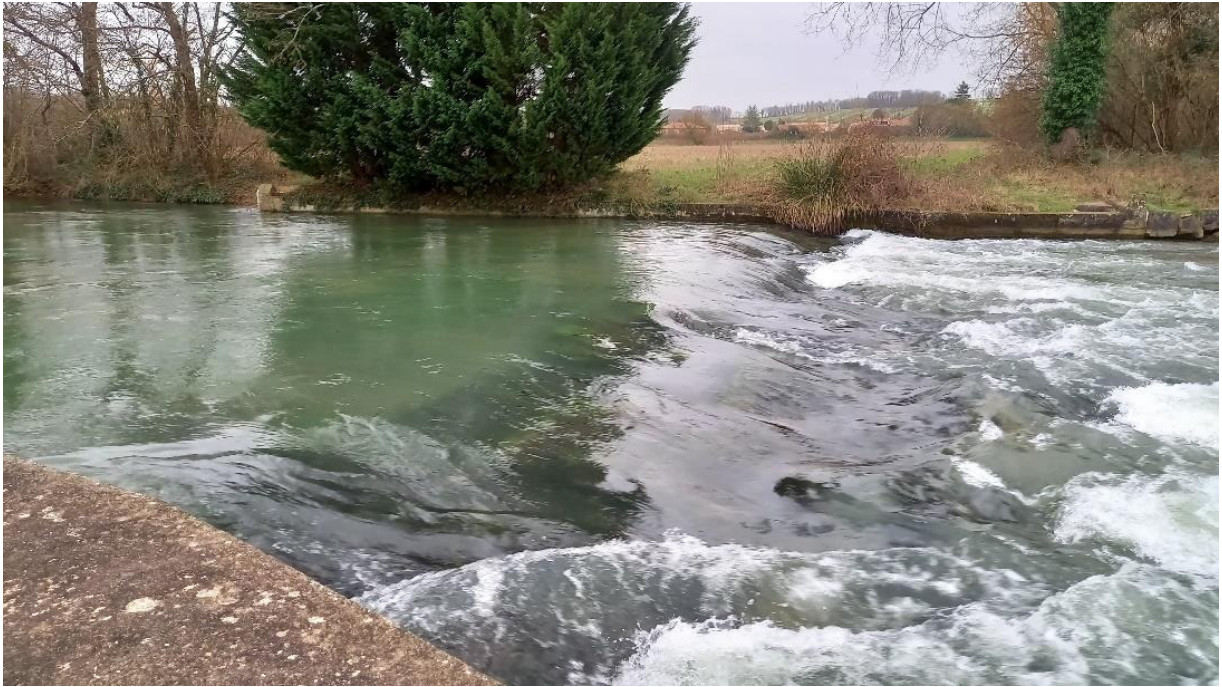
Figure 10 : Seuil de la Trache amont moulin du Roy. Point d'injection du débit réservé et de sa mesure potentielle en situation sans végétation. Le seuil est hétérogène avec un amoncellement de bloc en aval immédiat.
