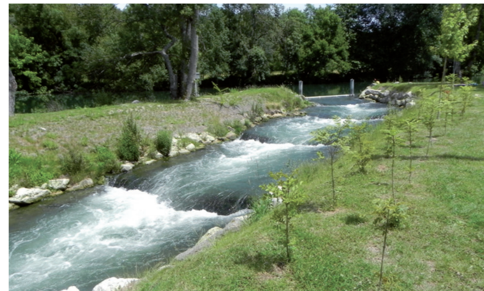
Passé à poissons de Gademoulin sur la Charente
