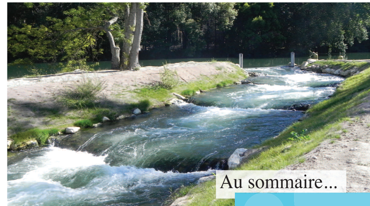
Dispositif de franchissement à Gademoulin (Charente)
