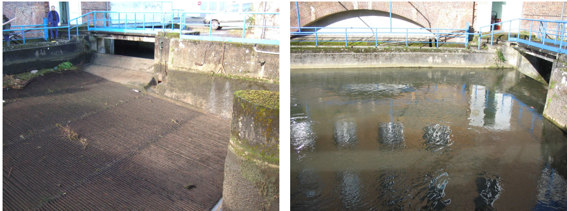
Figure 33 : Plan de grille fortement incliné ( \beta = 7^\circ ) de la centrale des Baquets sur la Risle ( \approx 12 \text{ m}^3/\text{s} ) (Photo Richard A.)
