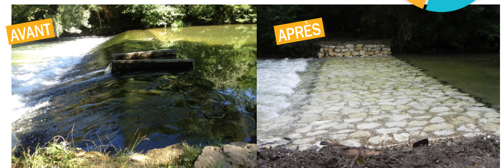
Seuil de Mérienne avant et après arasement à Jamac (16).
