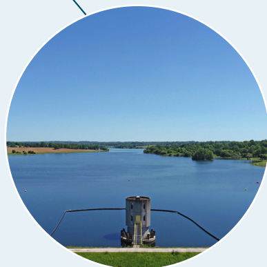
Barrage de Lavaud
