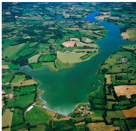
LE BARRAGE DE LAVAUD SUR LA CHARENTE AMONT
