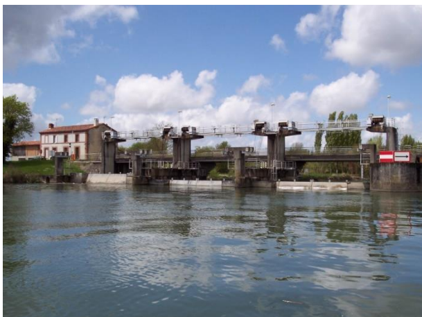
BARRAGE MOBILE DE SAINT-SAVINIEN
