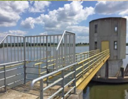
Sécurisation de l'accès au site : entrée de la passerelle rehaussée, remplacement de fixations, nouveau garde corps...
